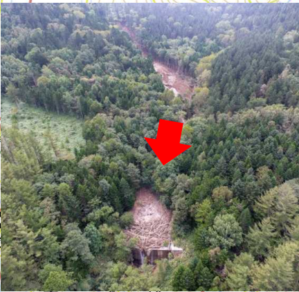
そらちぐん みなみふらののちよう おちあい 落合3の沢(北海道空知郡南富良野町落合) 土石流等 施設効果事例
