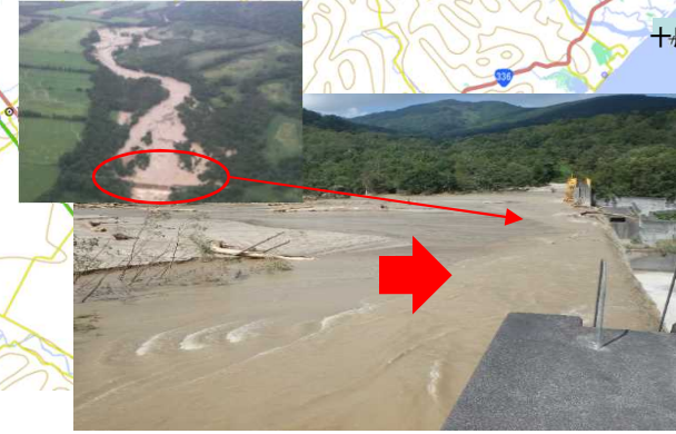
かみかわぐん しみずちよう しみず ペケレベツ川(北海道上川郡清水町清水) 土石流等 施設効果事例
