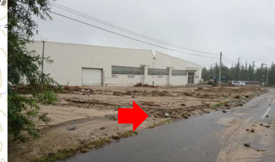
かみかわぐん しみずちよう はおび 造林沢川(北海道上川郡清水町羽帯) 土石流等 家屋一部損壊(一戸)
